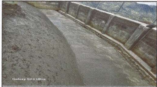
Foto 2: Reparación de piso de cemento líquido
