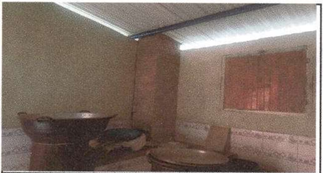
Foto 6: Pintura en muros interiores
