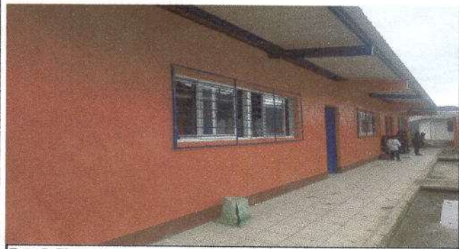
Foto 5: Pintura en muros exteriores
