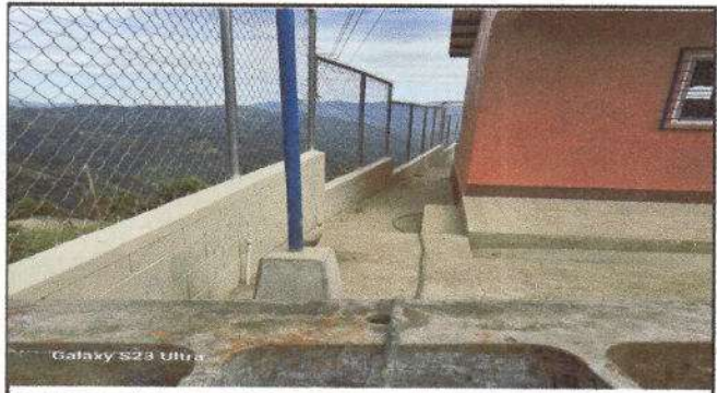
Foto 4: Pintura en muros exteriores
