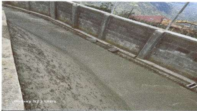
Foto 3: Sustitución de banqueta de concreto
