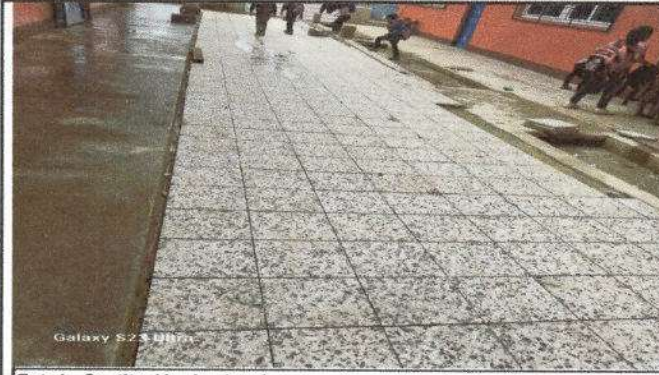
Foto 1: Sustitución de piso de cemento por piso de granito
